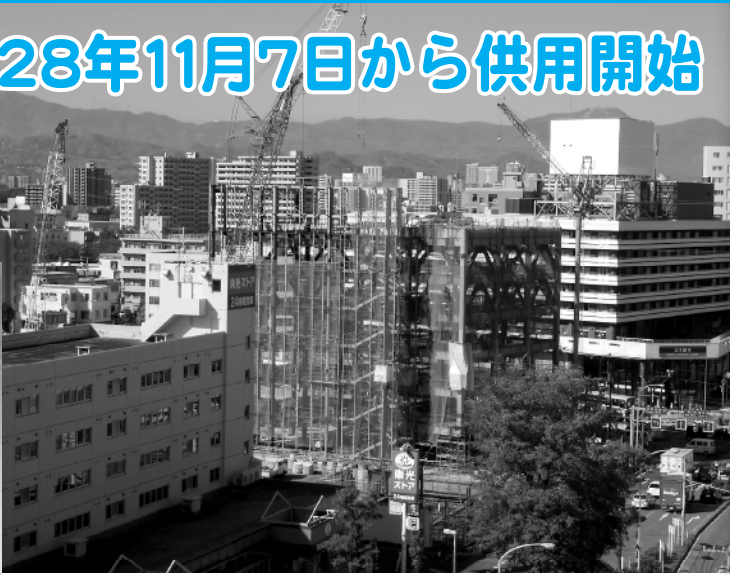
建設工事が進む白石区複合庁舎
